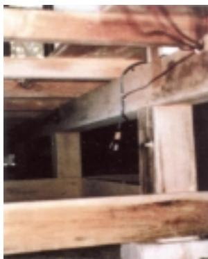
木炭を敷設する前の床下。結露によりカビが発生している
